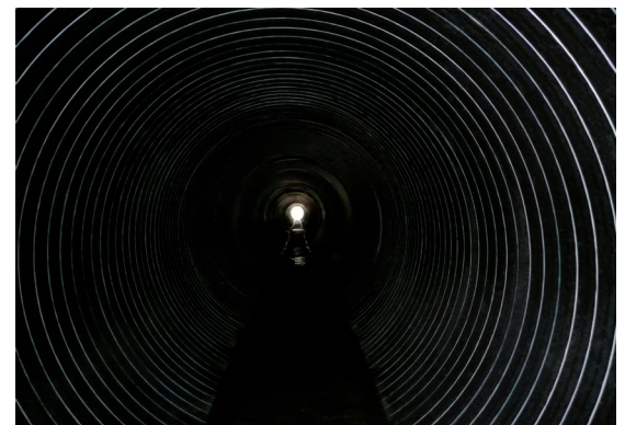
Готовая труба SPR™ PE, на которой отчетливо видны соединенные между собой профили при помощи термосварки
