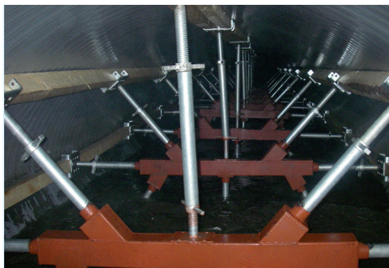
Опорная конструкция в процессе заполнения межтрубного пространства
